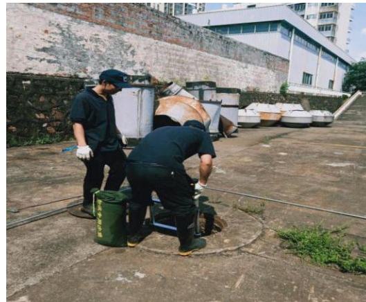
雨水总排口旁应急人员防护措施、应急梯及抽水泵
